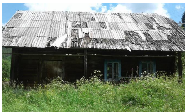
Бойківська хата в селі Головецько Стрийського р-ну (колишній Сколівський р-н) Львівської області. На світлині – залишки колишнього покриття драницями, зверху накрито шифером.
