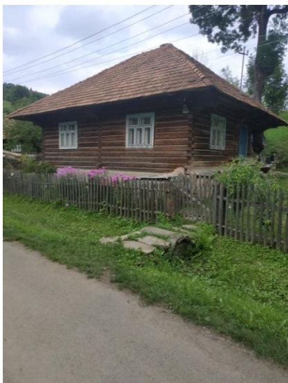
Бойківська хата з дахом на чотири схили («барацький верх») (кутове з'єднання без випуску) в селі Нижній Студений Хустського р-ну (колишній Міжгірський р-н) Закарпатської обл.
