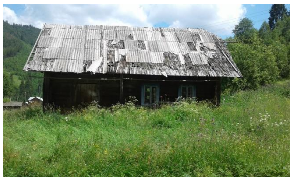
Бойківська хата в селі Головецько Стрийського р-ну (колишній Сколівський р-н) Львівської області. На світлині – залишки колишнього покриття драницями, зверху накрито шифером.
