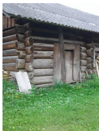
Кутове з'єднання з випуском («простий угол») у господарському приміщенні в селі Либохора Стрийського р-ну (колишній Сколівський р-н) Львівської обл.
